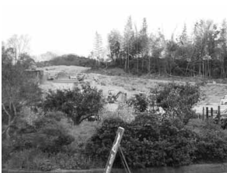
消防庁舎建設予定地(徳田地内)
