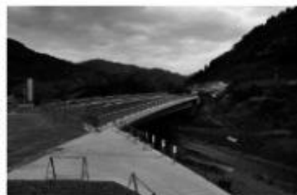
2010年10月に完成した新吉田橋
