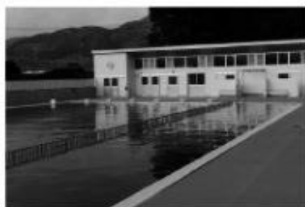
御霊小学校プール
