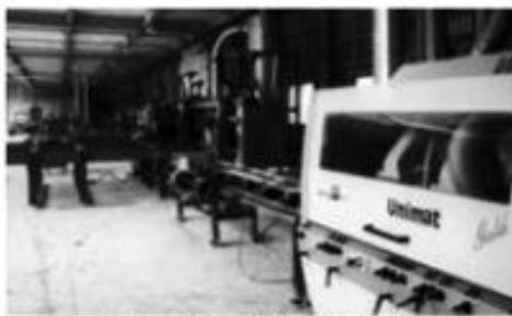
木材加工施設（瀬水西ノ原地区）
