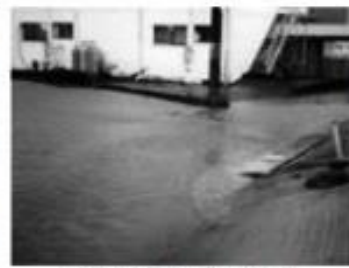
金屋庁舎周辺の浸水状況(2)
