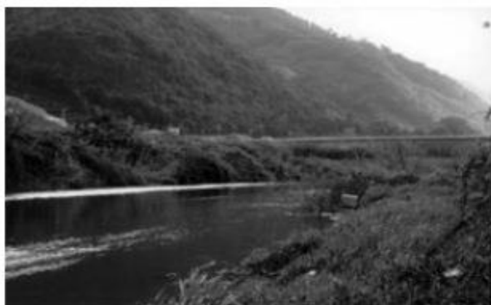
吉備橋～田殿橋間では、堆積土砂は2mにも達し、豪雨による堤防の決壊が心配される。
