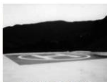
防災ヘリポート(清水橋本地内)
