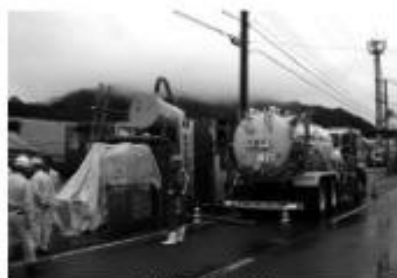
下水道工事現場
