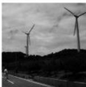
長峰に立つ風力発電施設
