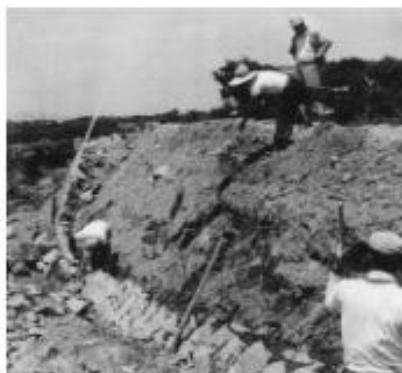
昭和32年当時の工事現場
