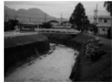
浚渫された有田中央高校付近（烏尾川）
