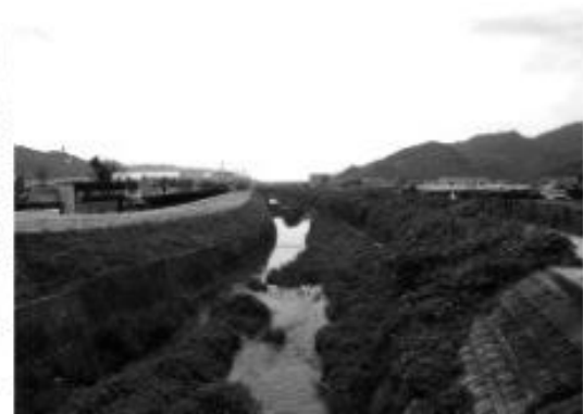
水質事故が発生した鳥尾川
