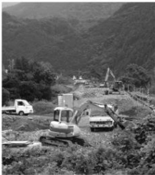
岩野河バイパス工事(国道480号)
