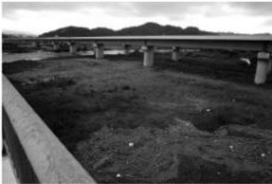
浚渫された田殿大橋下（有田川）
