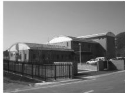
吉備浄化センター（下津野地区）
