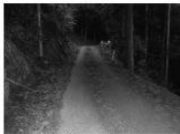
維持管理が必要な町道
