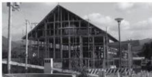
建設中の鉄道交流館
