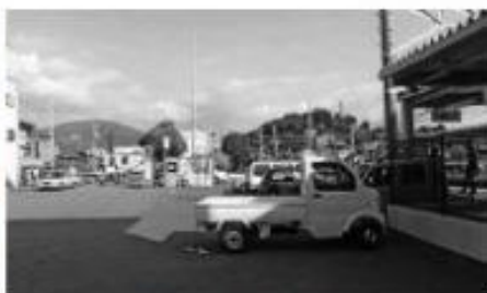
JR藤並駅西口の改修現場
