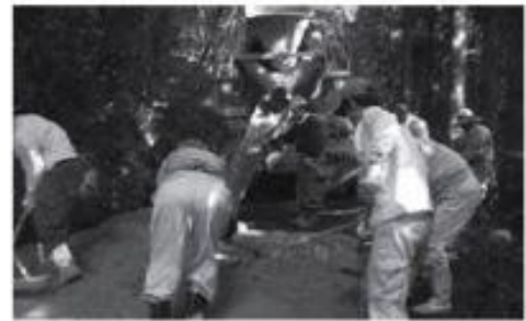
住民による町道の舗装工事
