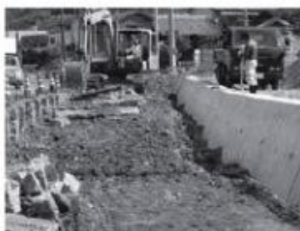
国道拡幅工事が進む島屋城小学校跡地
