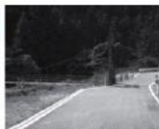
早期改修が望まれる二澤観音堂への橋
