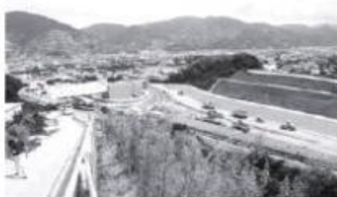
高速道路、インター工事現場
