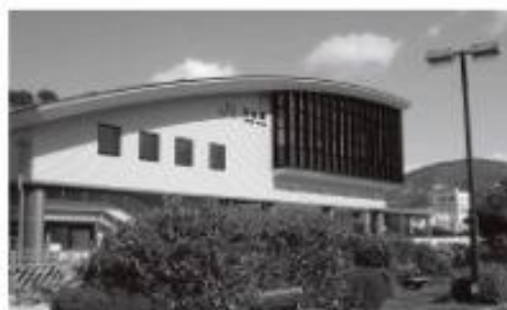
藤並駅を起点として巡回バス運行が計画されています
