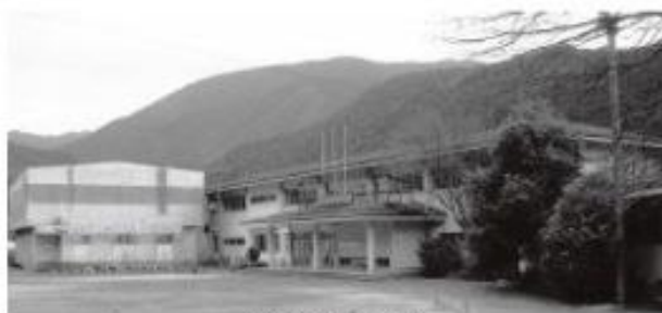
廃校舎(旧山口小学校)
