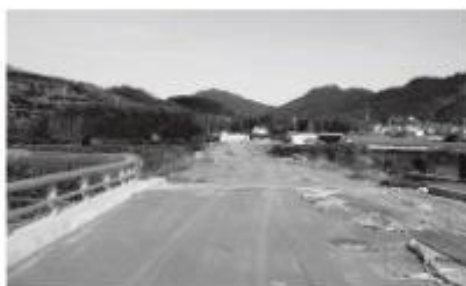
市場バイパス第1期工事現場
