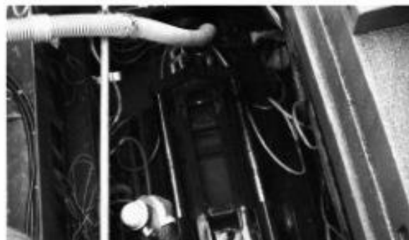
下水道、推進工事現場
