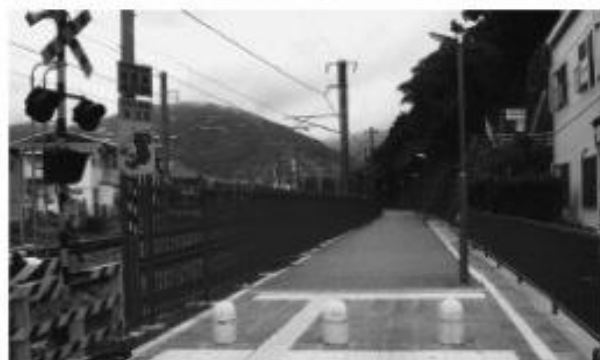
一部完成の遊歩道
