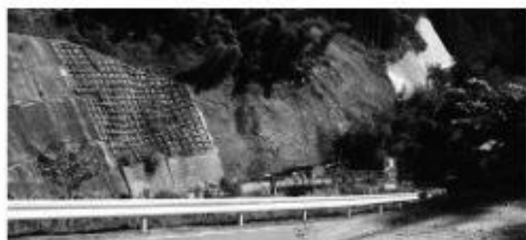
林道三瀬川清水線復旧工事
