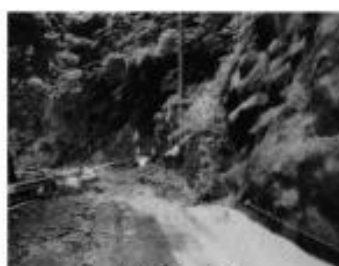
土砂くずれの現場
