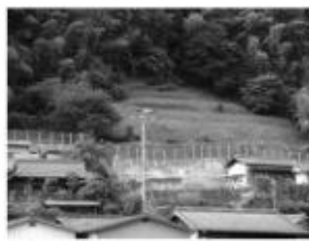
急傾斜対策の完了したところ（葉生地内）
