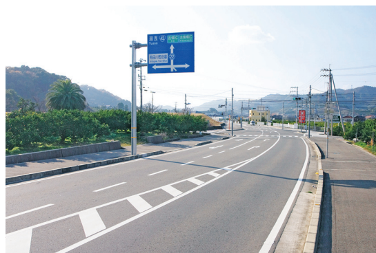
吉備金屋バイパス（主要地方道吉備金屋線）
