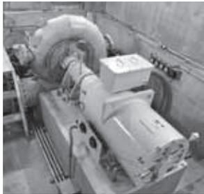
二川ダムでは、下流域の環境維持のため毎秒約700リットルの放流が常に行われています。有田川町営二川小水力発電所は、この環境維持放流水の水流エネルギーを利用し発電しています。この発電所の収益は、循環型社会の構築と自然エネルギーの利用促進のために役立てられています。環境にも町財政にもエコな発電所です。
